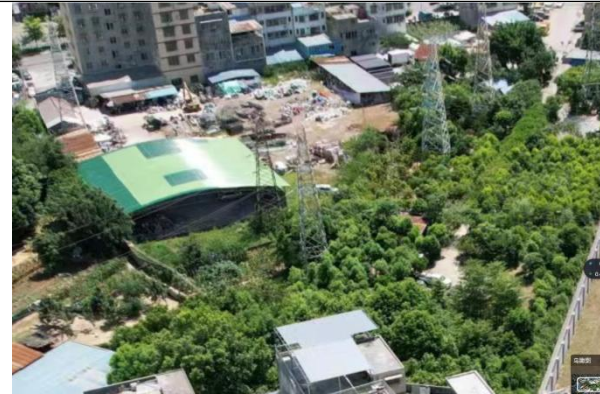
220kV 阳山站出线侧
